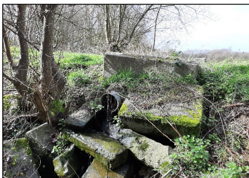
Exutoire Bassin n°3
